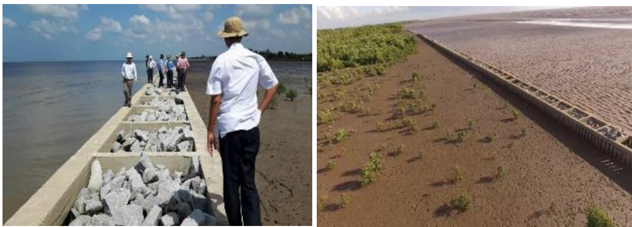
Hình 0.13: Hình ảnh kè chống sạt lở bằng cọc BT ly tâm kết hợp đá hộc
