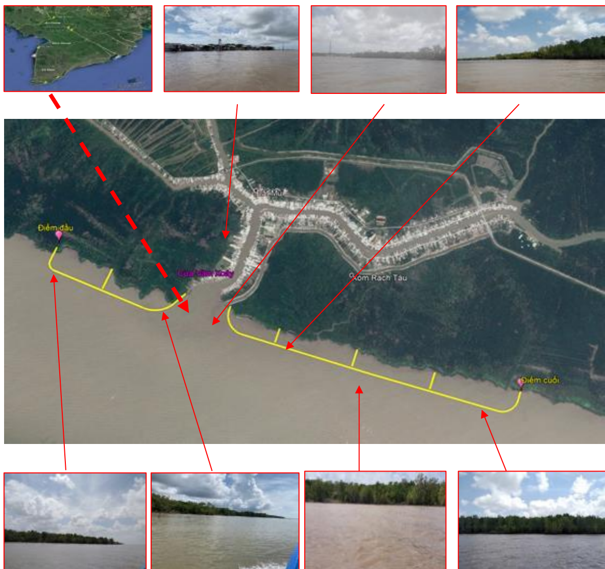
Hình 0.6: Vị trí tuyến kè vùng cửa biển Vàm Xoáy, tỉnh Cà Mau
